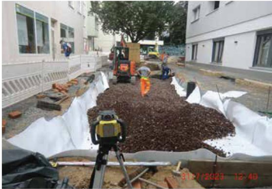
kornabgestuftes Baumsubstrat mit Abdichtung
